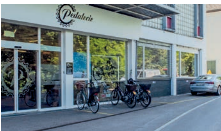
Veloparkplätze in einer gemeinsamen Anlage für Mitarbeitende und Kunden.
