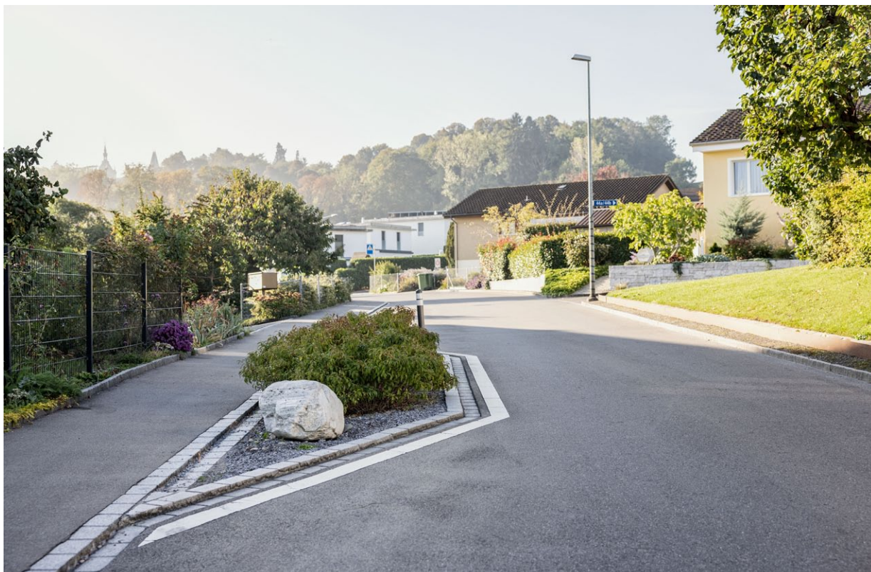
Seitliche Einengung als Gestaltungs- massnahme in einer Tempo-30-Zone
