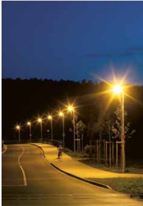
Gleichmässig ausgeleuchtete Strasse: Die Velofahrerin ist gut sichtbar. Foto: Trilux GmbH
